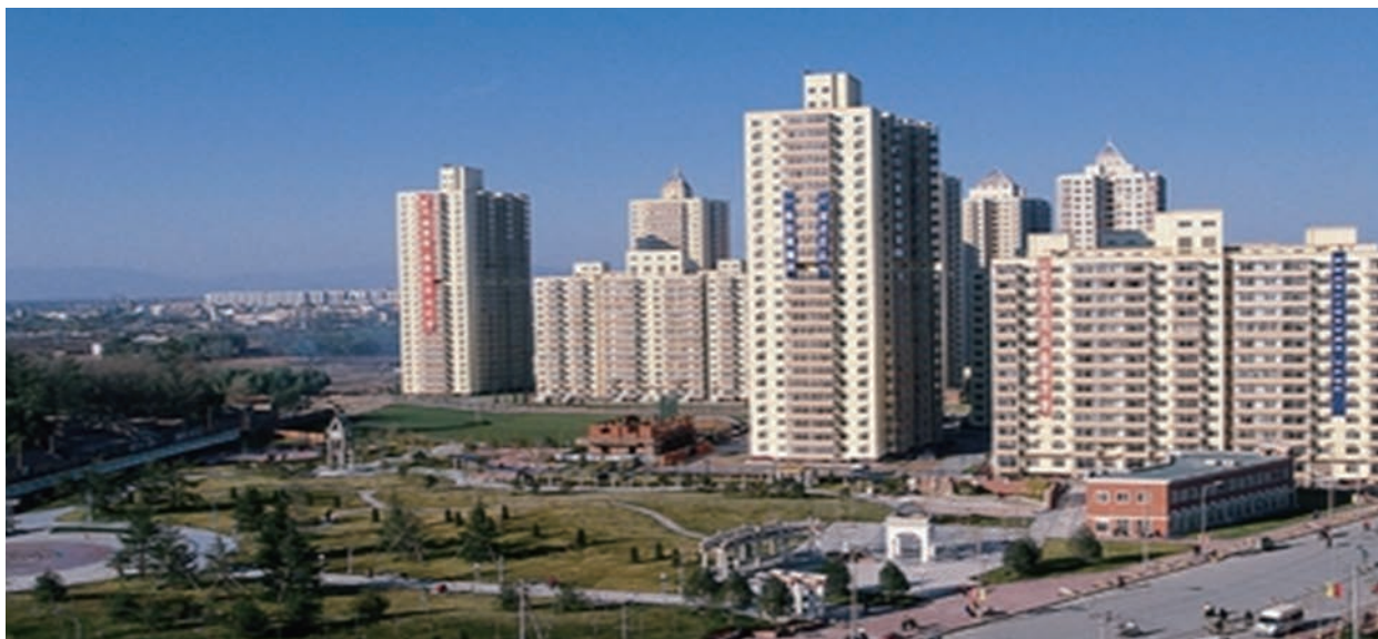
北苑家园综合地热供暖项目
