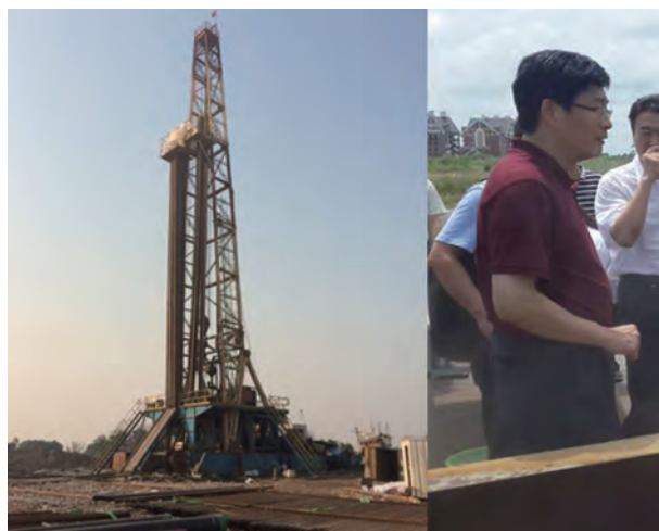
▲ 图 8 小洋口地区洋通地热 2 井钻进过程与放喷试验现场
