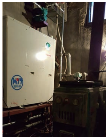
改造后热泵主机(安装于原锅炉房)
