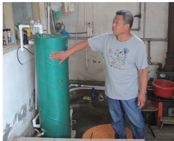
试点用户白大爷家安装的地能热泵系统配套热水罐
