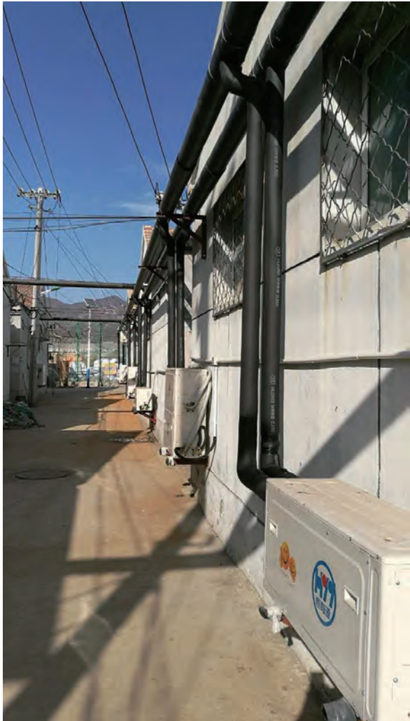
地能输送管网及地能热宝末端室外机
