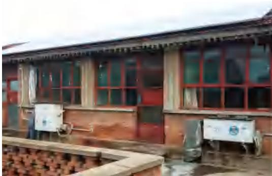
Рис.19 Наружная установка геотермальной энергии, установленная перед домом
