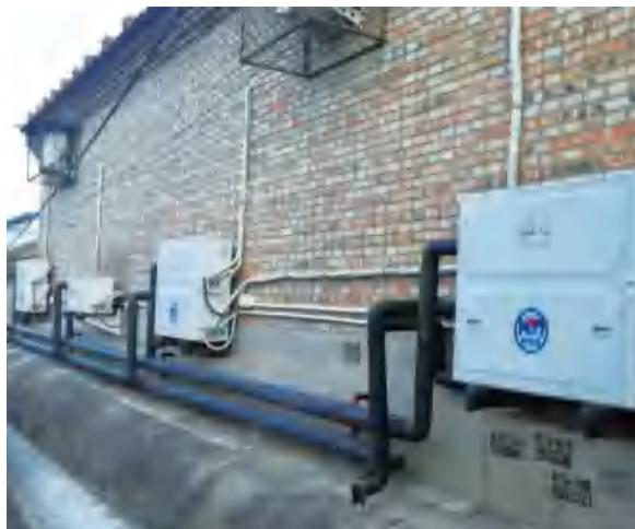
Рис.16 Наружный блок геотермальной установки ThermoPower, установленный в задней части дома
