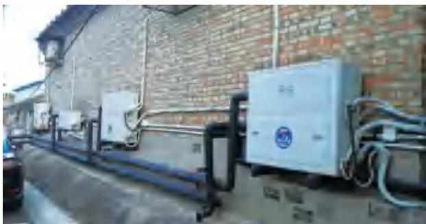
图 16 安装在屋后的地能热宝室外机
