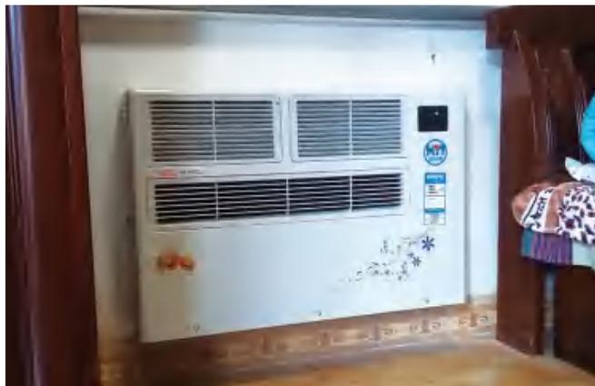
Рис.18 Внутренний геотермальный радиатор ThermoPro, установленный в доме
