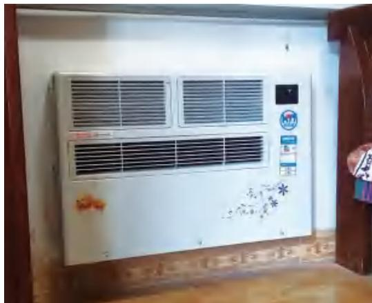
图 18 安装在屋内的地能热宝室内散热器
