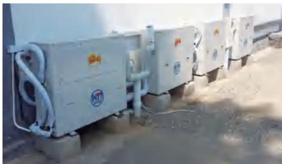
图 17 安装在屋后的地能热宝室外机
