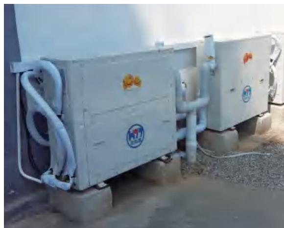
Рис.17 Наружный блок геотермальной установки ТермоПауэр, установленный в задней части дома
