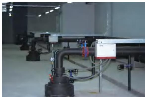
Рис.12 100-процентная постройка в подвале Национального театра. Односкважинные рециркуляционные теплообменные скважины для улавливания геотермии с односкважинной подпиткой
